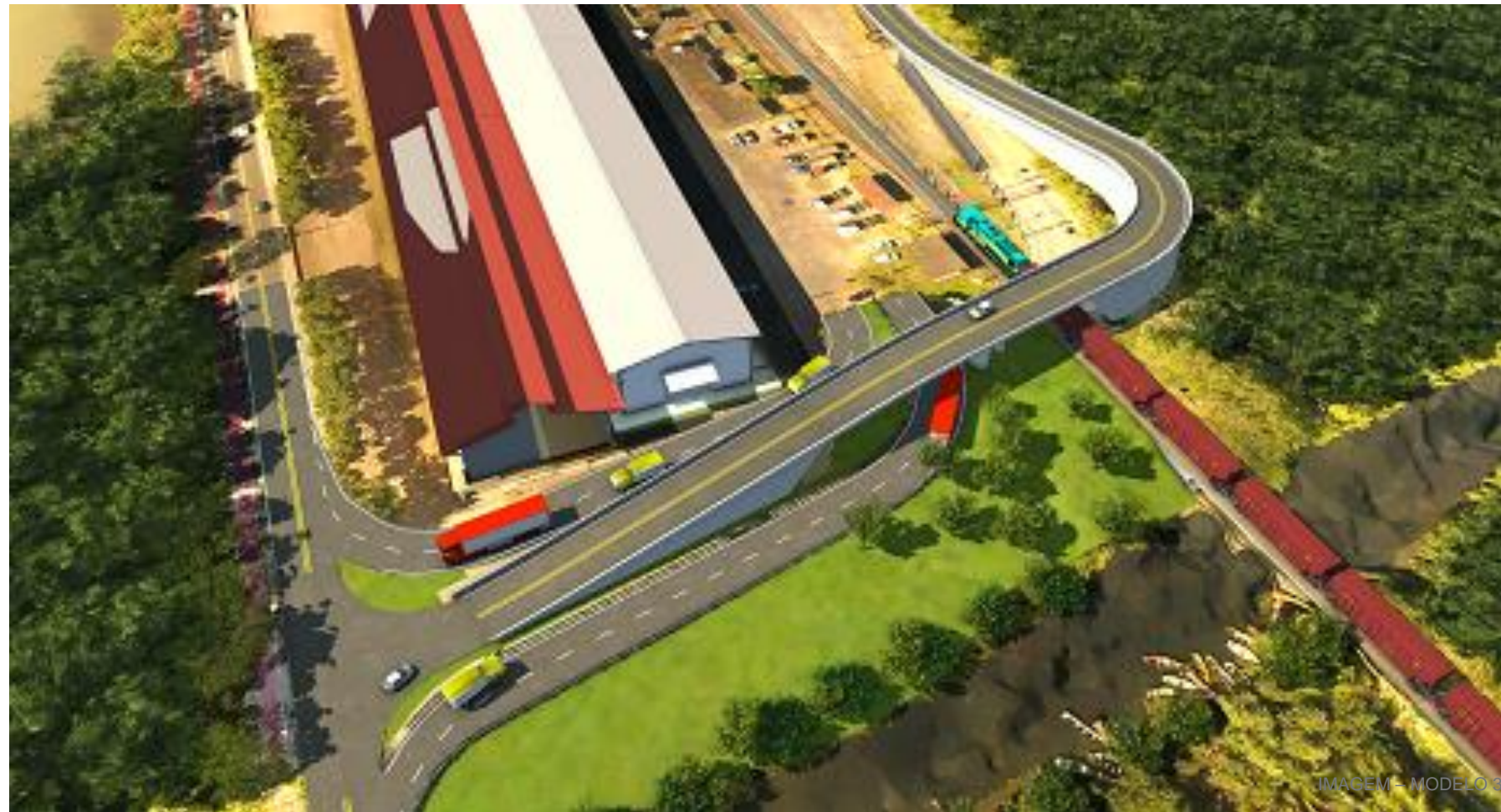
Viaduto Itacibá e Vedação - Município de Cariacica/ ES
