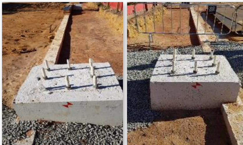
algumas bases da fundação concluídas
