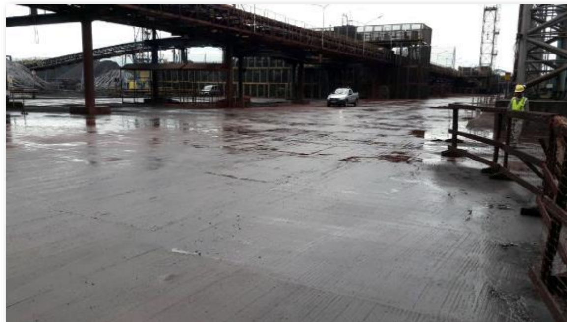
concluída a pavimentação da cabeceira do pátio de carvão
