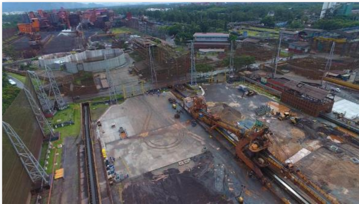
em obra - pavimentação da cabeceira do “pátio área velha”
