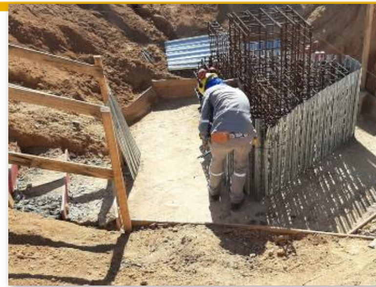
obras civis das bases da estrutura
