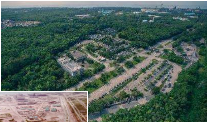
Implantação do Cinturão Verde em dezembro de 1982, antes do início de operação da usina
