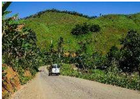
Revsol aplicado na via
